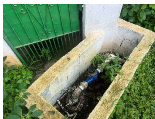
Poço Pedras Brancas I
