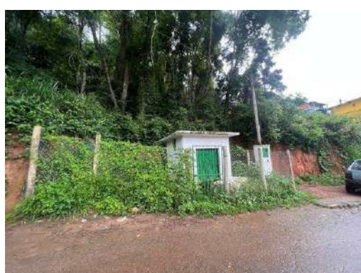
Poço Pedras Brancas I
