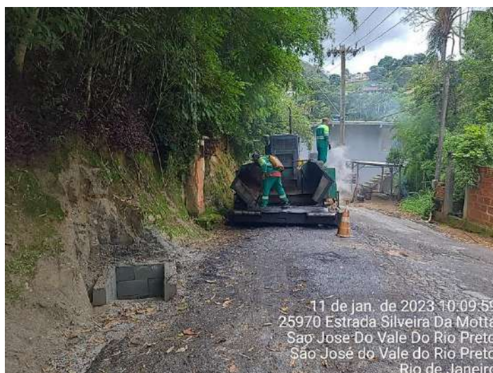
Figura 102 - Execução de obra de pavimentação e drenagem urbana. Fonte: SERENCO.
