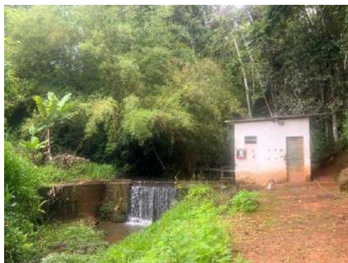
Captação de água bruta
