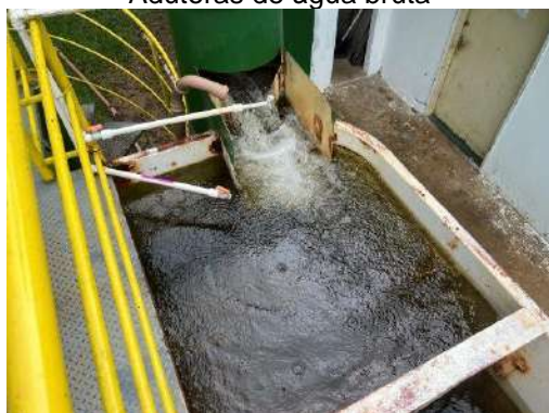
Mistura rápida e aplicação de coagulante
