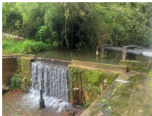
Captação de água bruta
