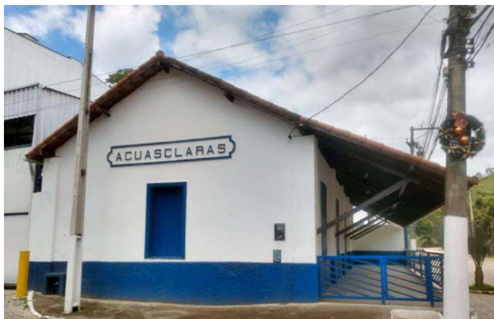
Figura 30 - Estação Águas Claras Fonte: O Trem Expresso, 2020.
