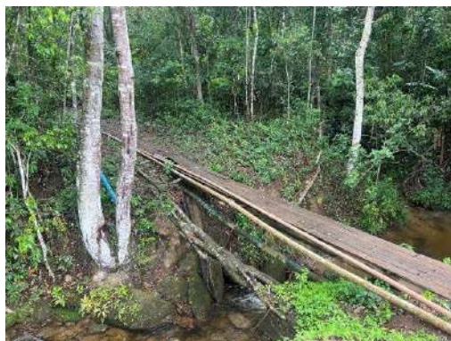
Adutoras de água bruta
