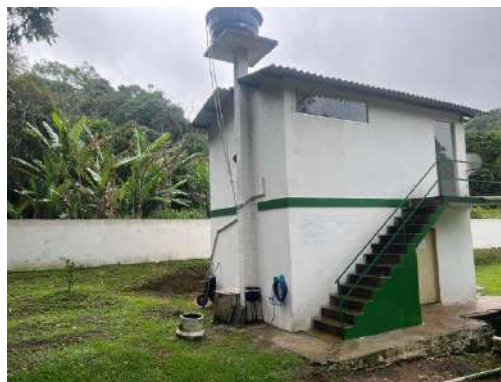
Edificação de apoio
