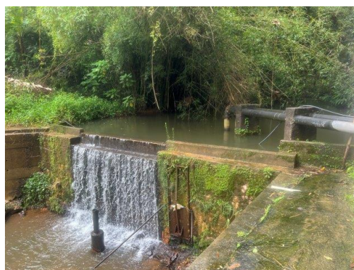
Captação de água bruta
