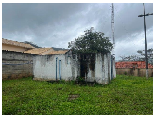
RAP Centro (concreto - 100 m 3 )
