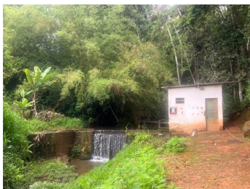
Captação de água bruta
