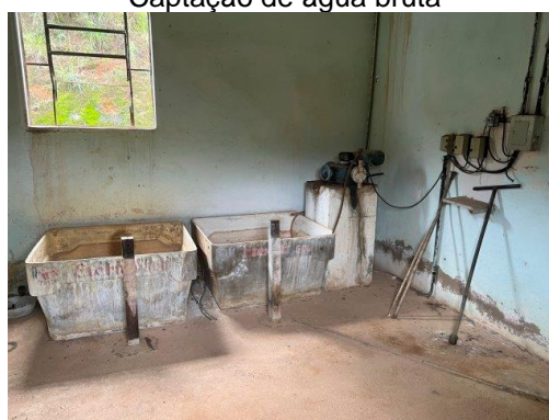
Estrutura de apoio desativada
