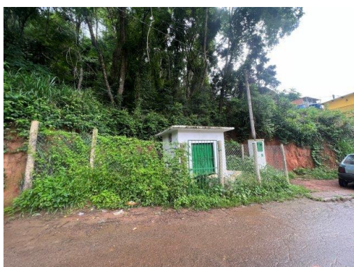
Poço Pedras Brancas I
