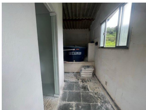
Preparo e dosagem de produtos químicos
