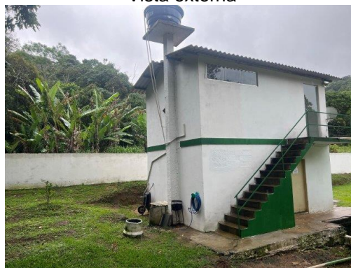
Edificação de apoio
