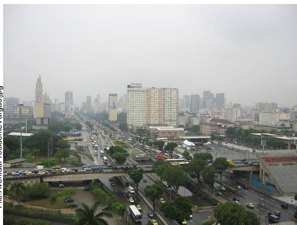
Av. Presidente Vargas, vista do prédio onde era a sede da antiga Telerj. 2017.
